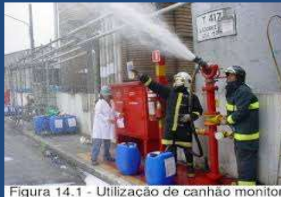
Figura 14.1 - Utilização de canhão monitor
