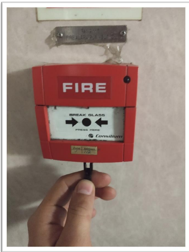
Figura 17: Teste de rotina dos manual call points.
