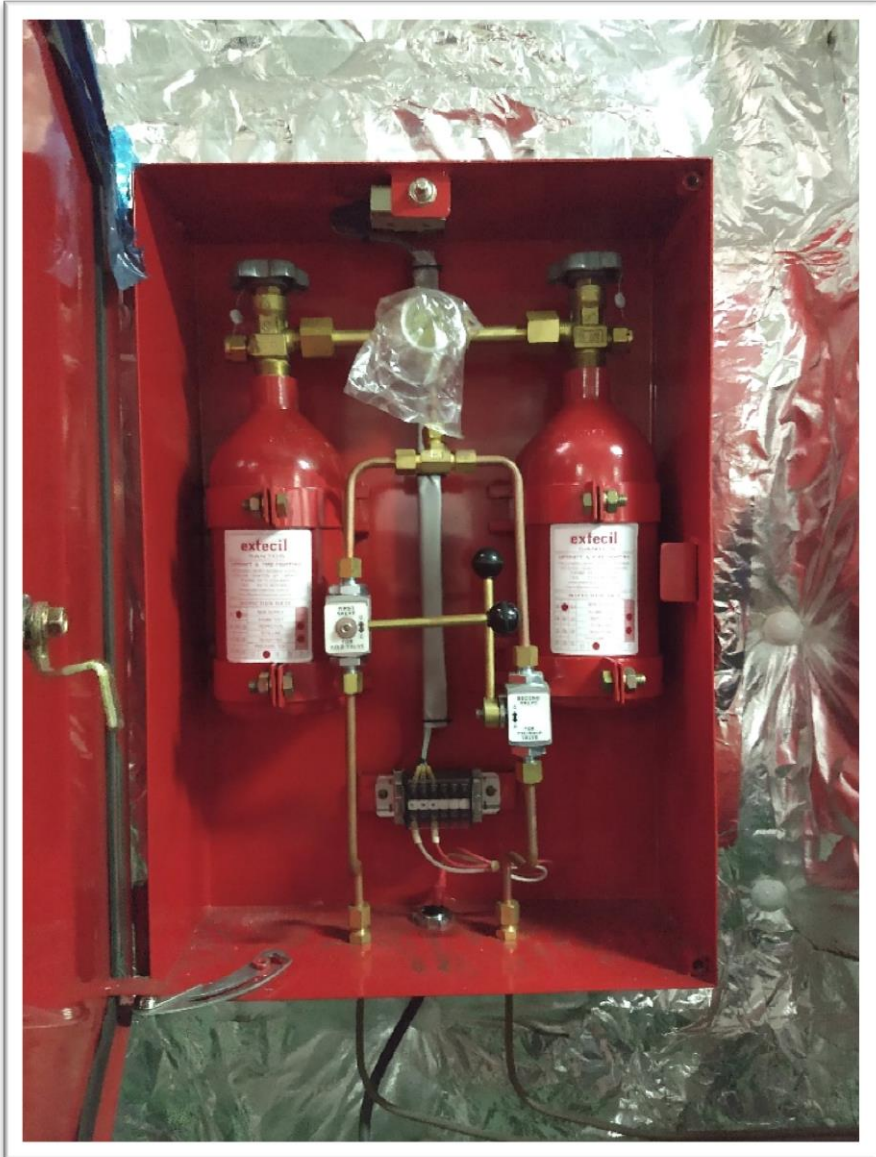
Figura 21: Cilindros-piloto do sistema fixo de Co2.
