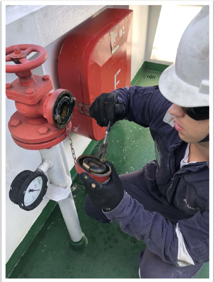
Figura 20: Manutenção de rotina nos postos de incêndio.
