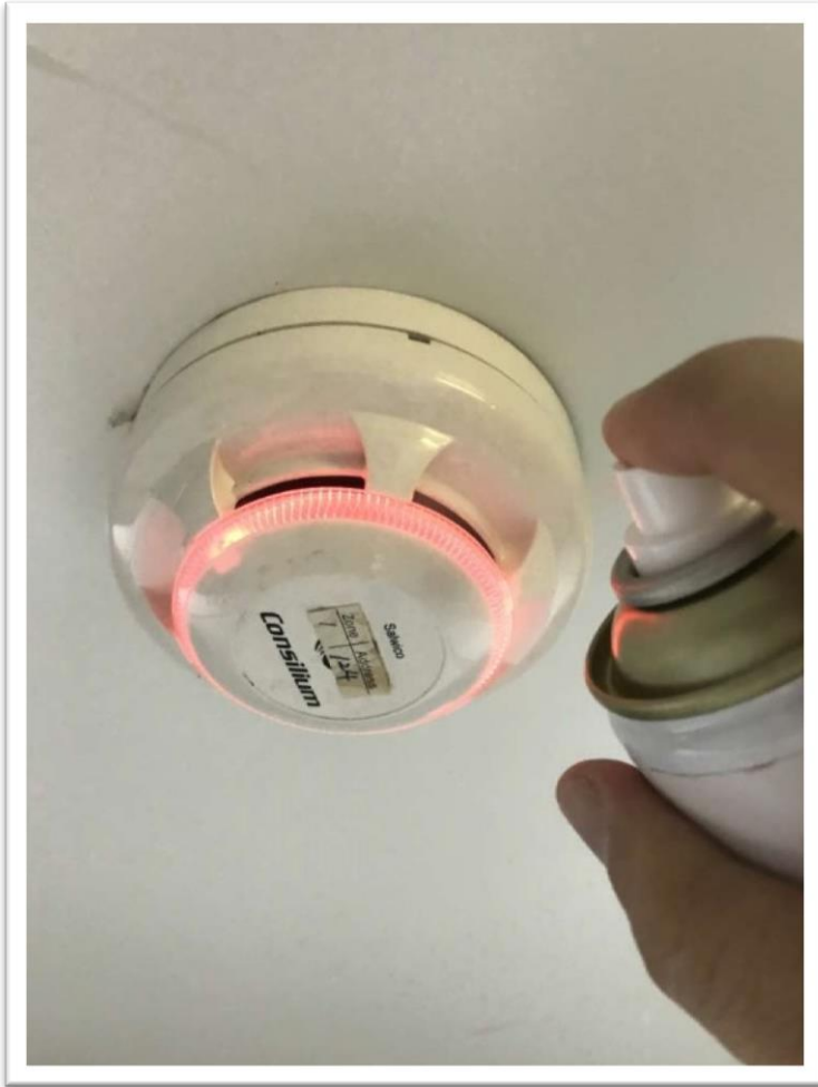
Figura 16: Teste mensal dos detectores.
