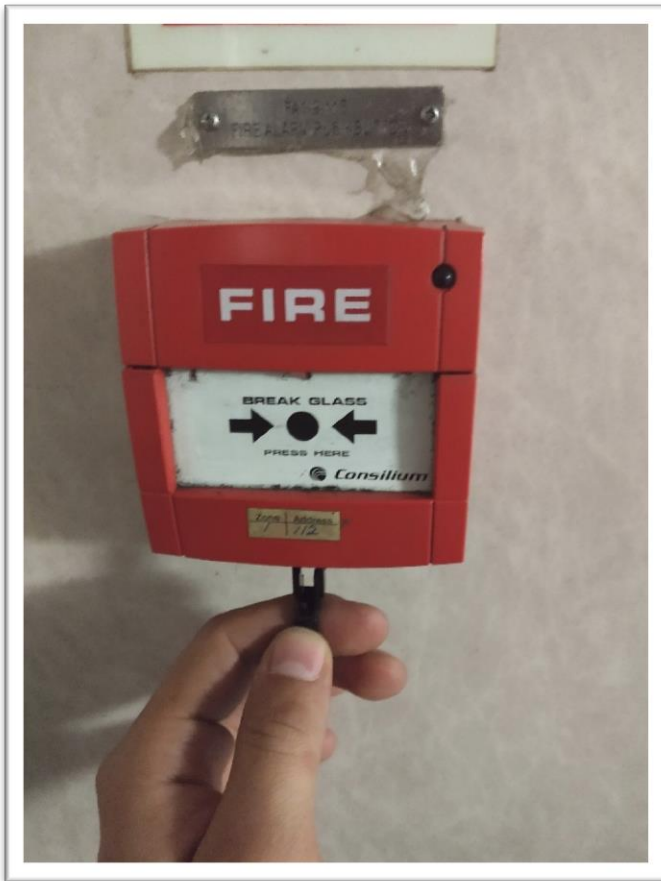
Figura 17: Teste de rotina dos manual call points.
